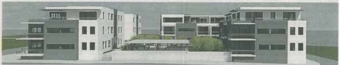
Auf rund 3700 Quadratmeter werden auf dem alten Krankenhausgelände vier Wohnquartiere gebaut.
