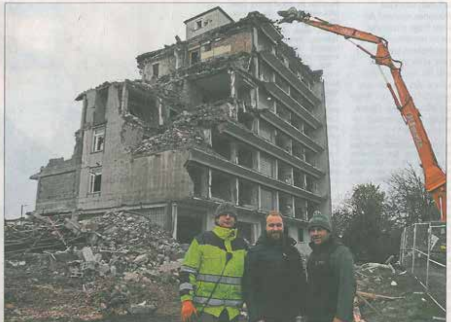
Polier Michael Hoidn (links), Projektleiter Silvan Gmeinder sowie Baggerführer Rainer Schnitzer sind zufrieden. Foto: Bloss
